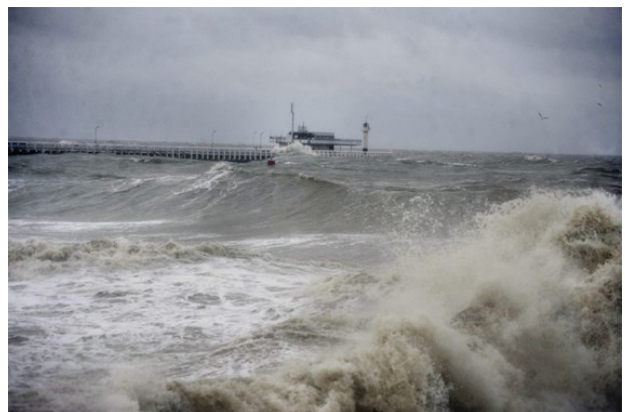
Afbeelding 14 : de pier van Oostende tijdens de storm
