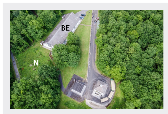
Afbeelding 19: luchtfoto van de situatie vóór de aanvang van de werken. Het bestaande gebouw is aangeduid met 'BE' en de plaats van de uitbreiding met 'N'.
